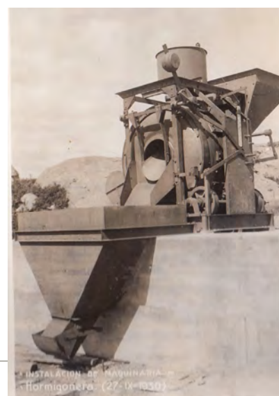
Alguna maquinaria que se fue incorporando desde 1925: Hormigonera y machacadora de mandíbula. Colección particular de Tomás Pérez Frías.
