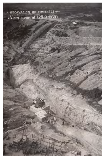
Vista general de los cimientos de la presa. 28-10-1930. Colección particular de Tomás Pérez Frías.
