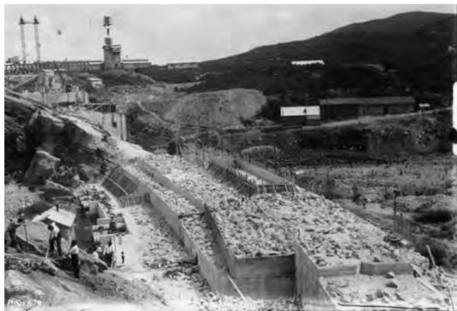
Obra de construcción de la Presa. AHP So. 679. Colección Tiburcio Crespo Palomar
