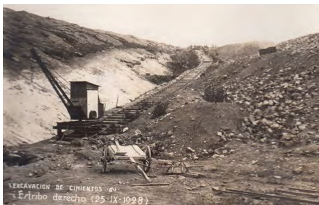
Excavación de cimientos. Estribo Derecho. 25-9-1928. Colección particular de Tomás Pérez Frías.
