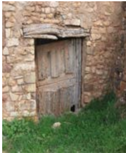
2. Tarancueña. Puerta de dos hojas de cuarterones y gatera con dintel de madera.
