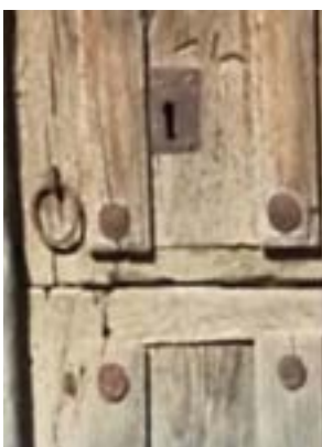
32. Puerta con tirador y embocadura en Caracena
