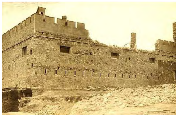
Fortín de Sammar en el que se pueden apreciar los destrozos de la guerra.
