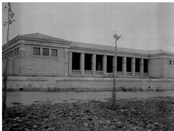
Fachada principal del Museo Numantino aun en obras (Archivo fotográfico del Museo Numantino).
