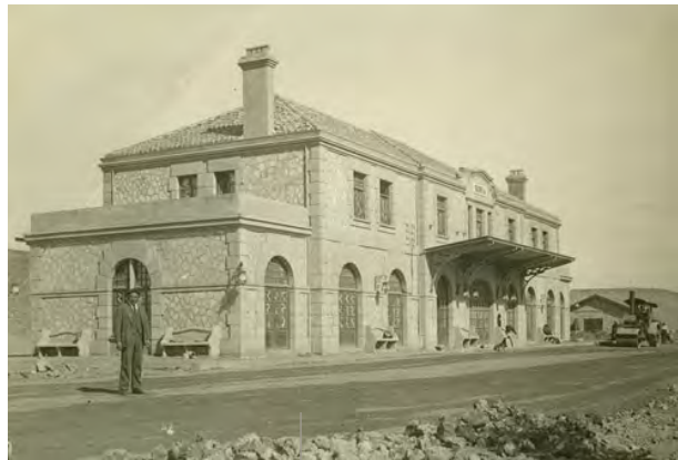
Estación de El Cañuelo (Soria) en construcción. Archivo General de la Administración.
