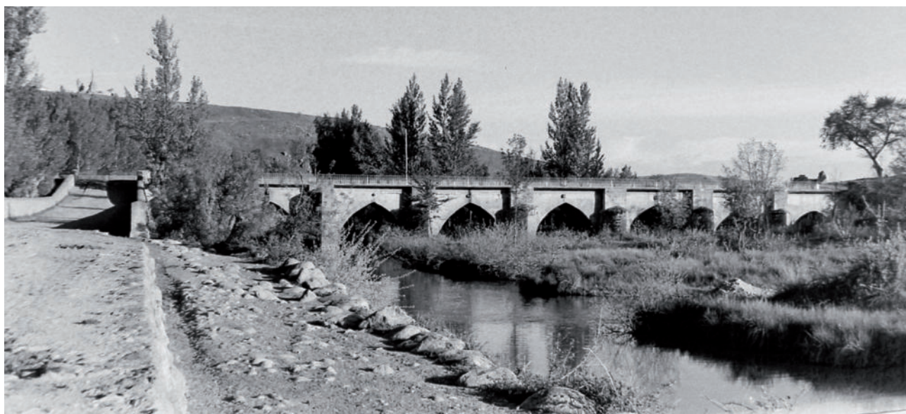
Costado del puente de Garray por el que discurre el Duero. A la izquierda el muro separador del Tera que fluye por el otro costado. Los dos ríos son uno sólo al otro lado de las arcadas
