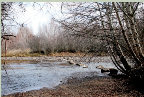
Restos de las antiguas pasaderas de Canredondo situadas aguas abajo y próximas a este embalse
