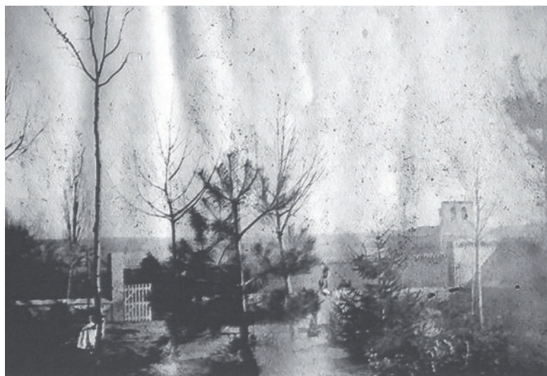
Antigua Iglesia de Quintana Redonda. Edificio destruido a causa de un incendio en el año 1918.
