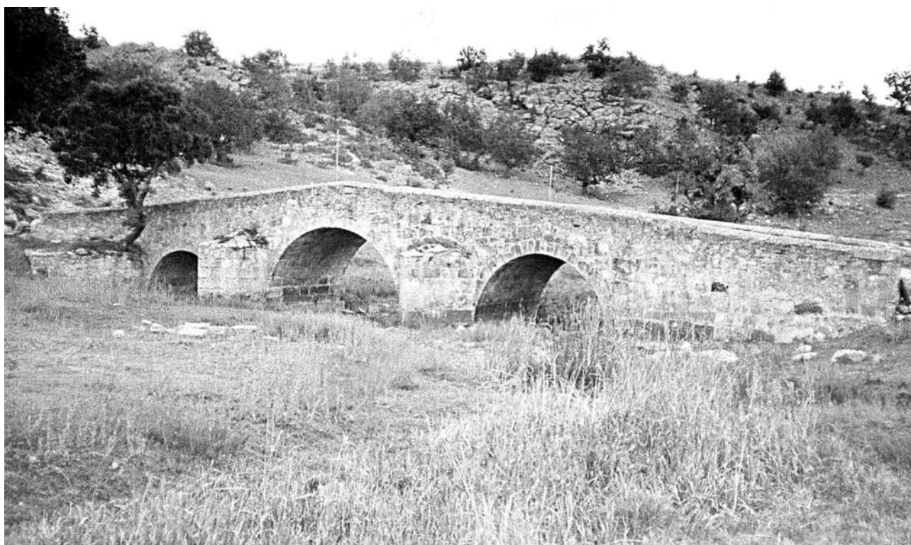
Puente del Canto sobre el arroyo Pedrajas
