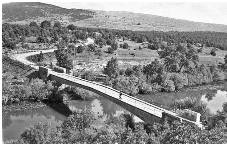
Puente de Hinojosa. Paso-camino vecinal de Toledillo a El Royo
