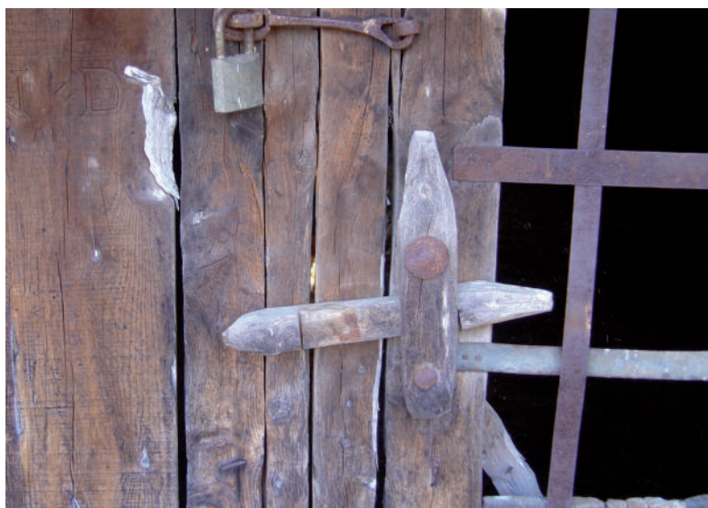
Ejemplo de pestillos empleados para cerrar la puerta de una paridera.
