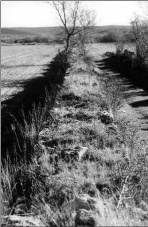
Fig.5.-Detalle de la coronación del muro de la Serna
