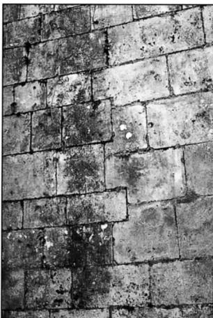
Fig. 2.—Muro construido en dos etapas, con sillares engatillados. Monasterio de Alcobaga.
