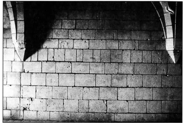
Fig. 3.—Paño de sillería donde se aprecia el despiece regular y los mechinales. Monasterio de Alcobaga.
