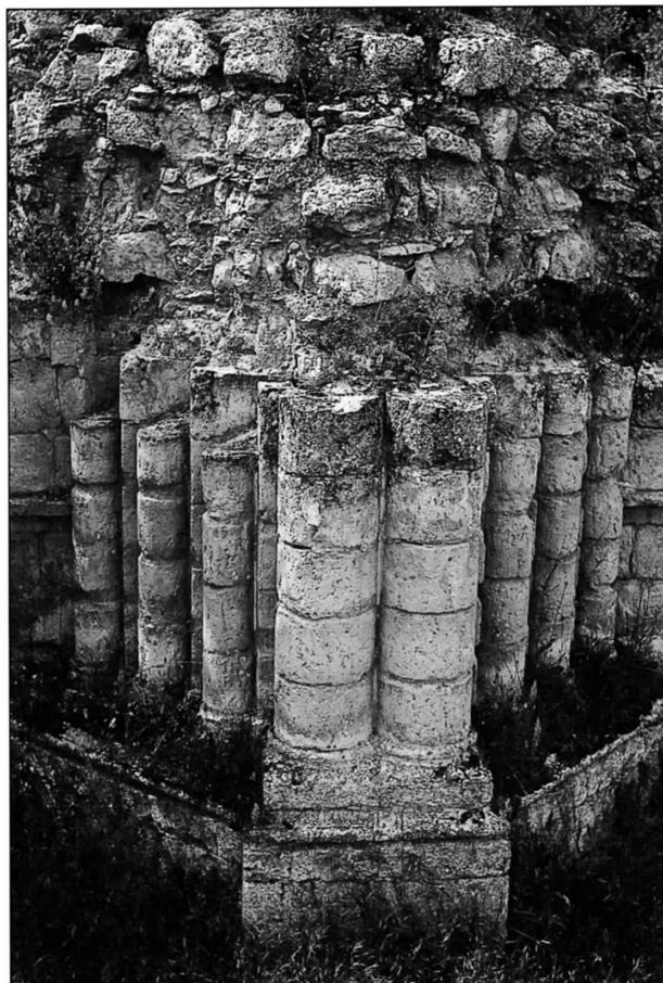
Fig. 6.-Pilar compuesto con haces de columnas. Ruinas del monasterio de Matallana.
