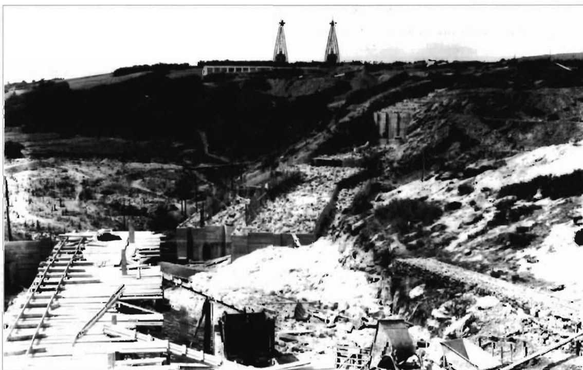
OBRAS PANTANO CUERVA DEL POZO
