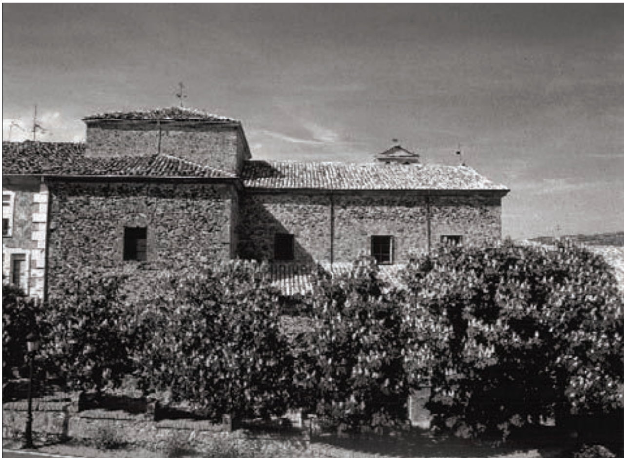
Exterior del convento desde la carretera de Vozmediano
