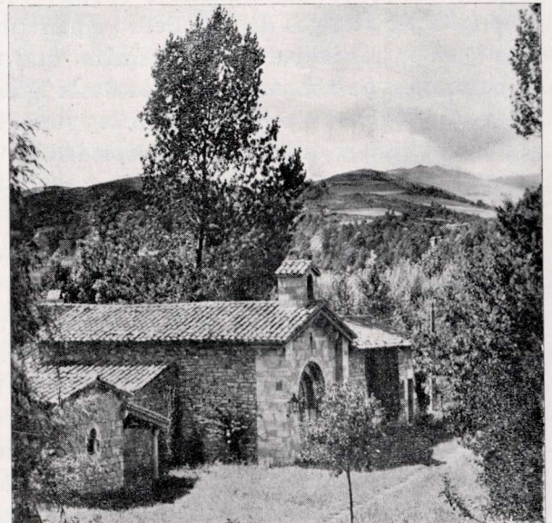
Vista general de los edificios en que se conservan los restos ornamentales de la iglesia de San Esteban.
