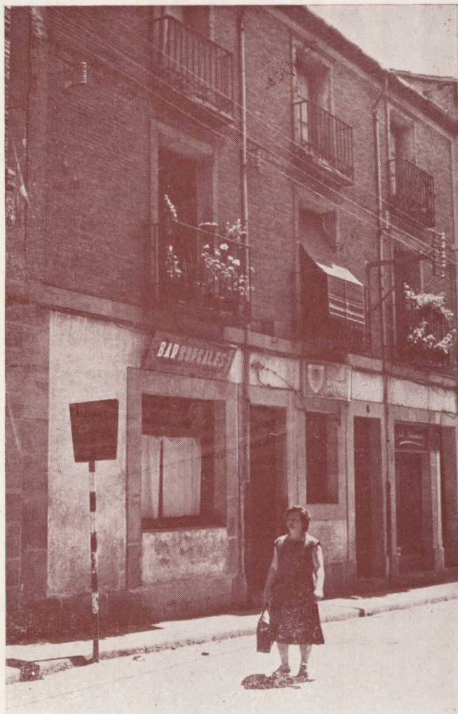
D. a Isabel Izquierdo tuvo también su pensión en este edificio de la calle de los Estudios
