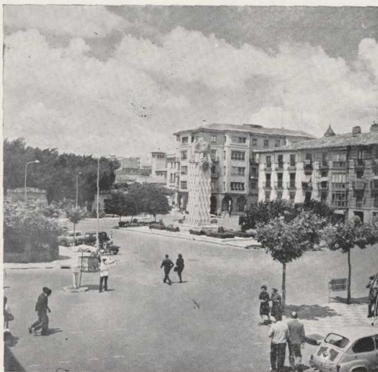
Al fondo la casa que ha sido derruida y que construyó D. Pablo del Barrio. Como caso curioso diremos que se empezó a construir por el tejado
