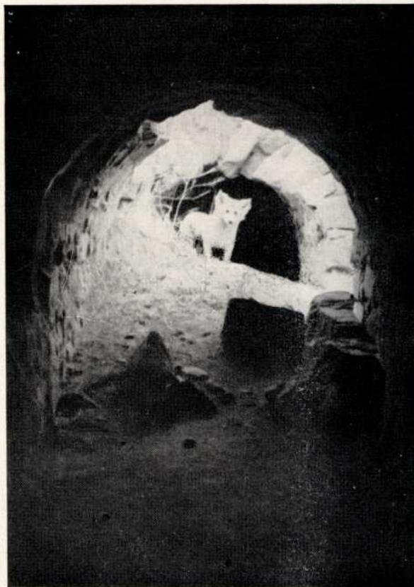
Galería alta abovedada que recorre los cuatro lados de la muralla del castro romano
