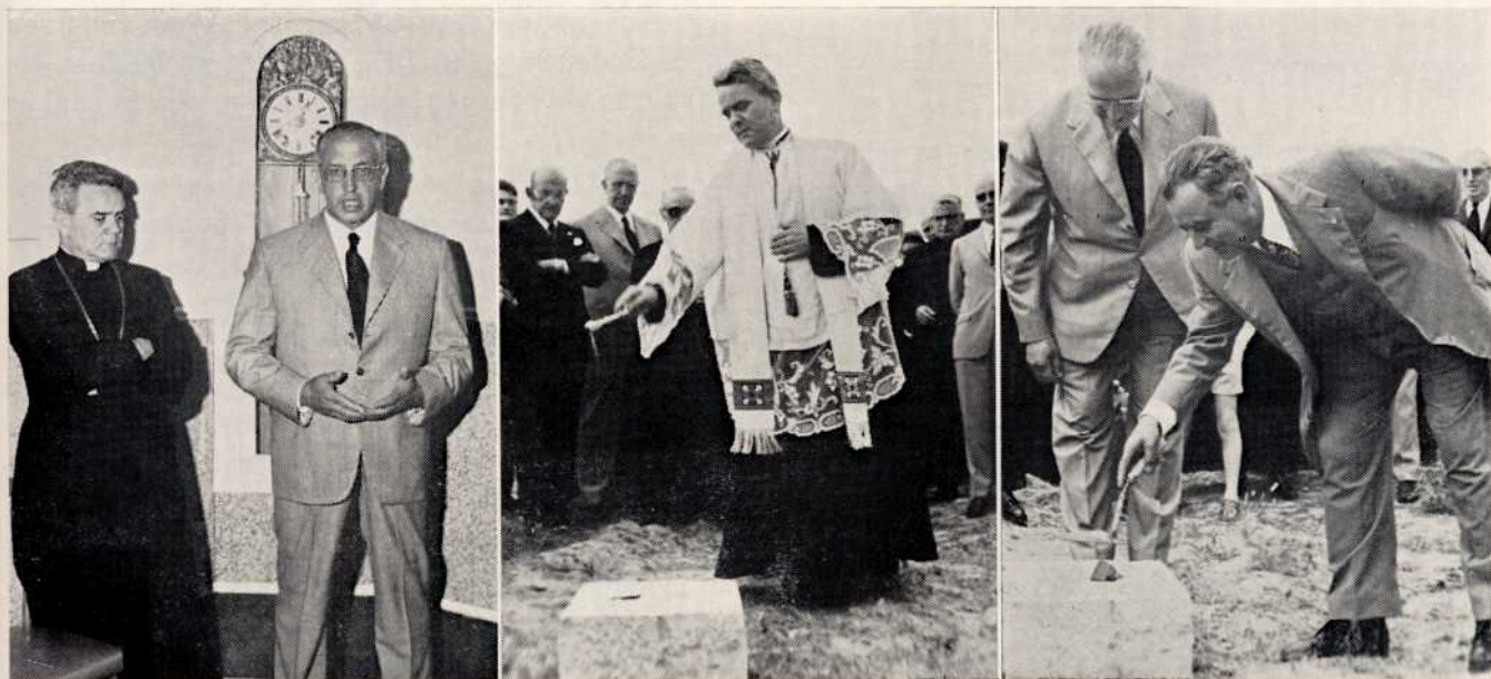
La fuente Caloto, recogió en su máquina tres momentos de la bendición y colocación de la primera piedra, de lo que será Residencia de Ancianos
