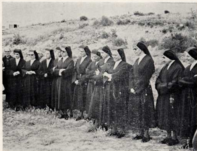
Sor Asistente y Hermanas de la Caridad presenciando la colocación de la primera piedra
