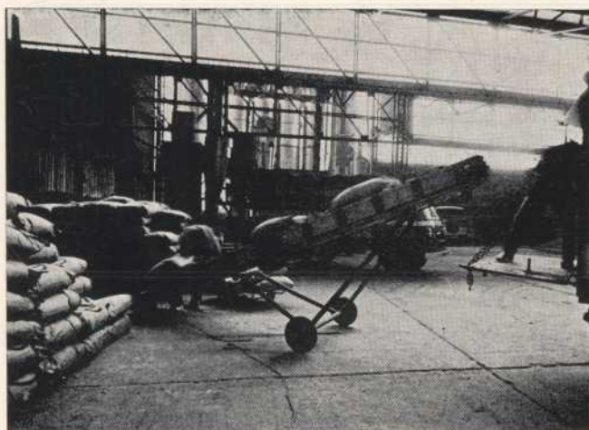
Panorámica interior de la Fábrica
