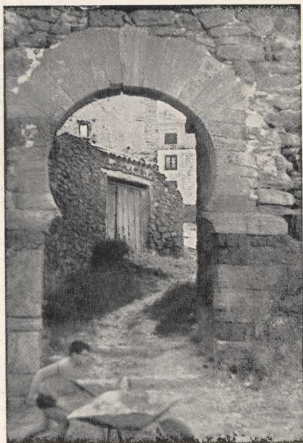
Puerta árabe del siglo X, en la muralla Este de Agreda
