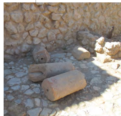
Restos de tuberías de alta presión?
