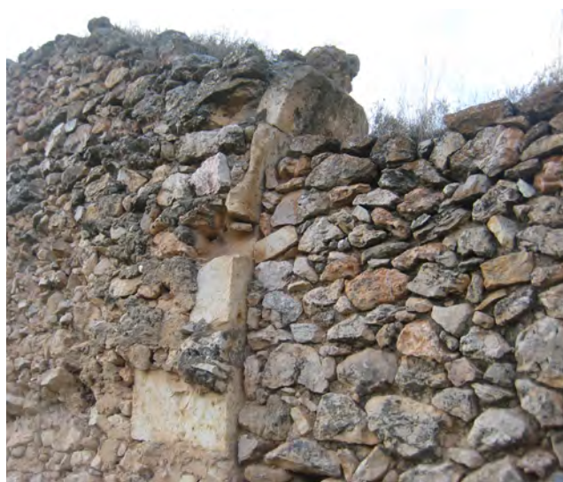
Posibles restos de arcada en la muralla del arrabal
