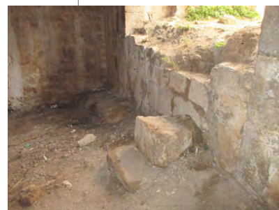
Muro de recrecimiento en la entrada del cubo “de Ciruela”
