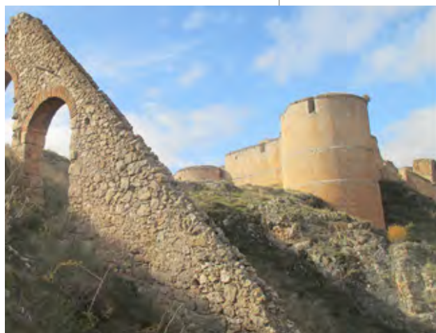
Parte superior del muro/acueducto
