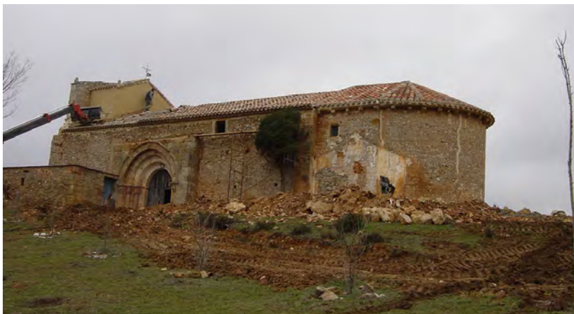
Ilustr. 2. Situación al poco de retirarse la sacristía, cuando se volvió a techar la nave, duran- te la intervención del año 2002
