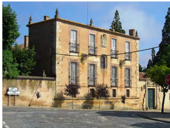
Fachada del Palacio que da a la carretera Soria-Berlanga.
