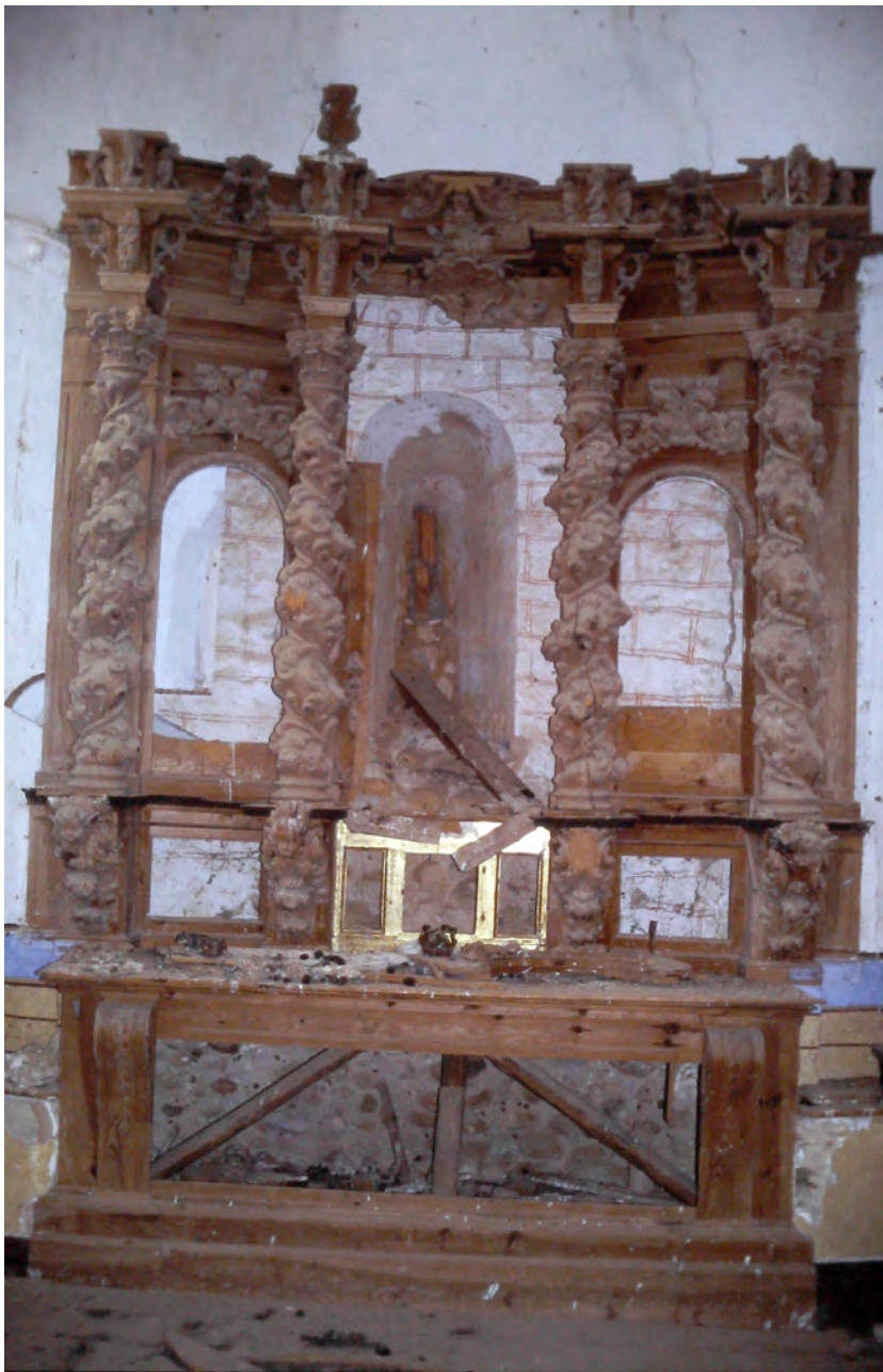
Ilustr. 12. Restos del retablo mayor, todavía in situ, antes de su desmontaje
