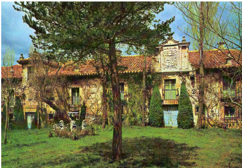
Palacio de Almarza de los González de Gregorio, también llamado de “Los Montenegro”, antes de la remodelación.
