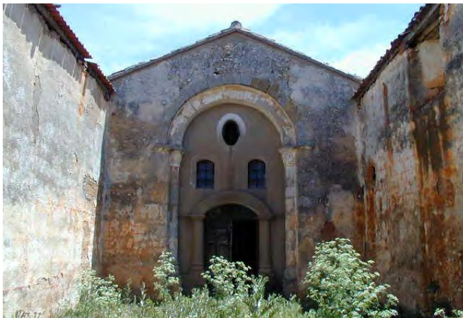
Ilustr. 9. Muro que aisló la cabecera del resto del templo, posiblemente levantado en la década de 1930
