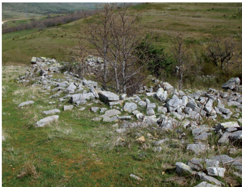
Fig. 19.-El Santo: derrumbes de la ermita.
