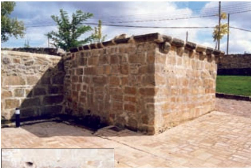
Figura 12. Fuente romana de Pozalmuro: estructura de tipo cambija.
