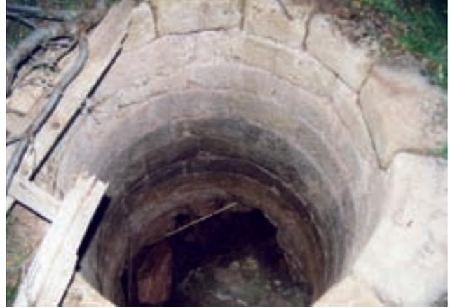
Figura 15. Pozo revestido de sillería en Castellanos.
