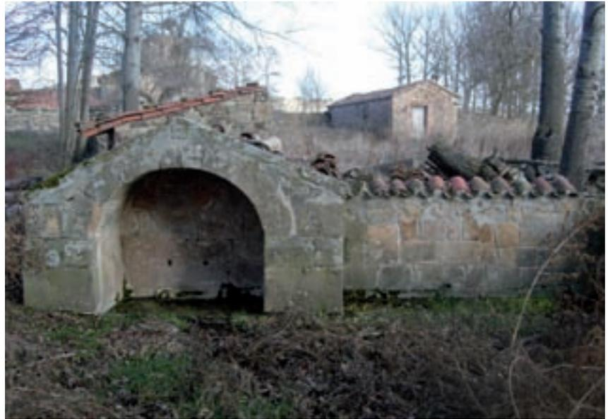
Figura 1. Fuente romana de San Gregorio, con arco de medio punto con tejadillo adosado a un muro.
