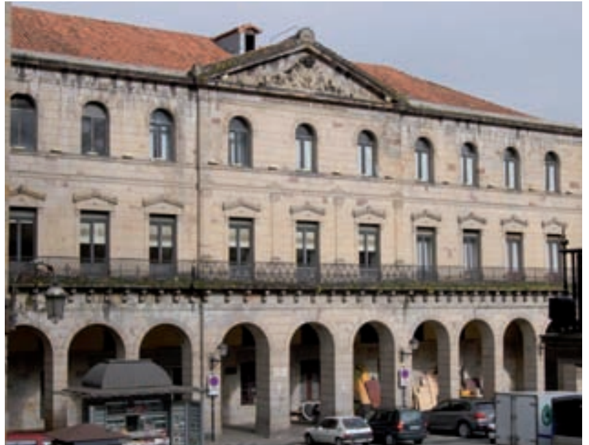
Foto actual del Real Seminario de Vergara.
