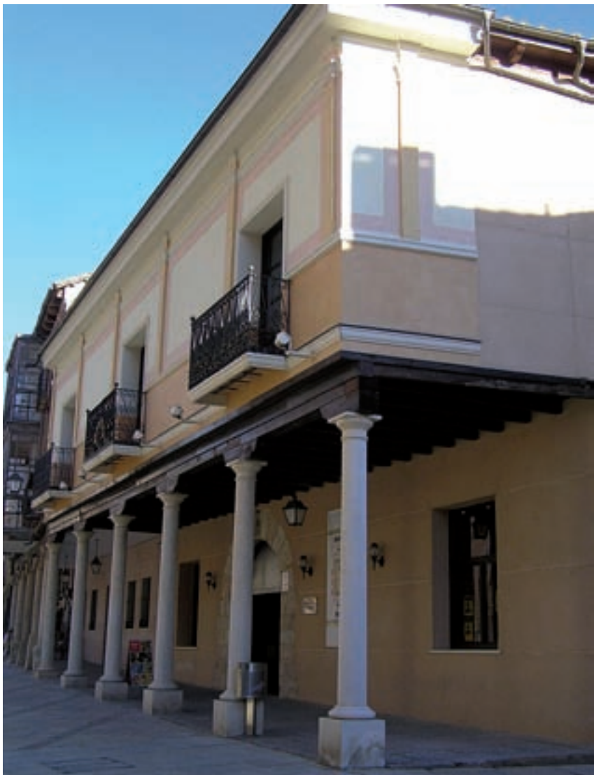
Fachada de Casa-Palacio de la Abadía de San Bartolomé en El Burgo de Osma.
