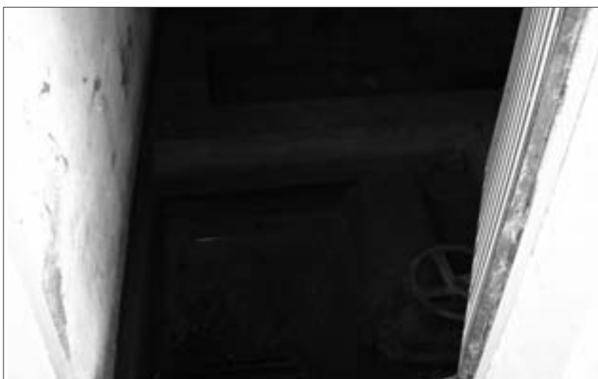
Arqueta en la captación de agua en Peñalagua.
