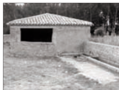
Lavadero y abrevadero recientemente restaurados
