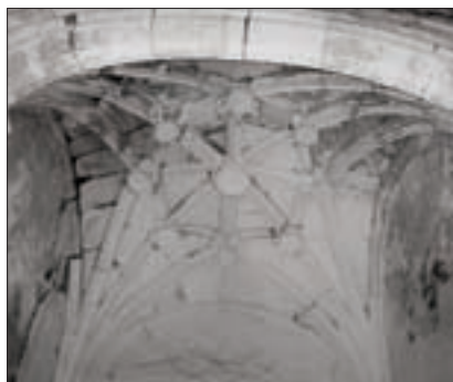
Bóveda de la capilla de la izquierda, norte, o del Evangelio de la Iglesia de Masegoso.
