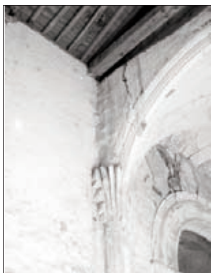
Fotografías donde se aprecian los arranques de las bóvedas en la nave central
