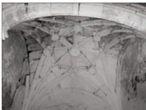
Fotografías donde se aprecian los arranques de las bóvedas en la nave central
