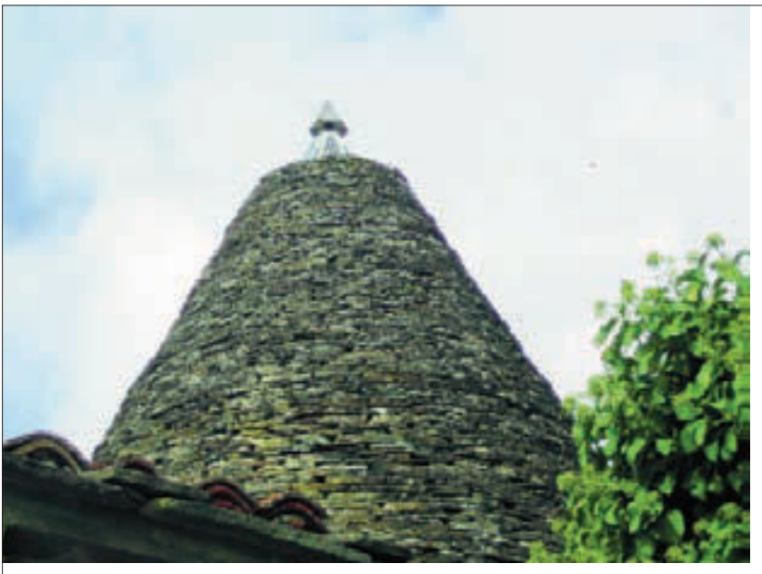
Chimenea pinariega realizada en losa en Espejo de Tera
