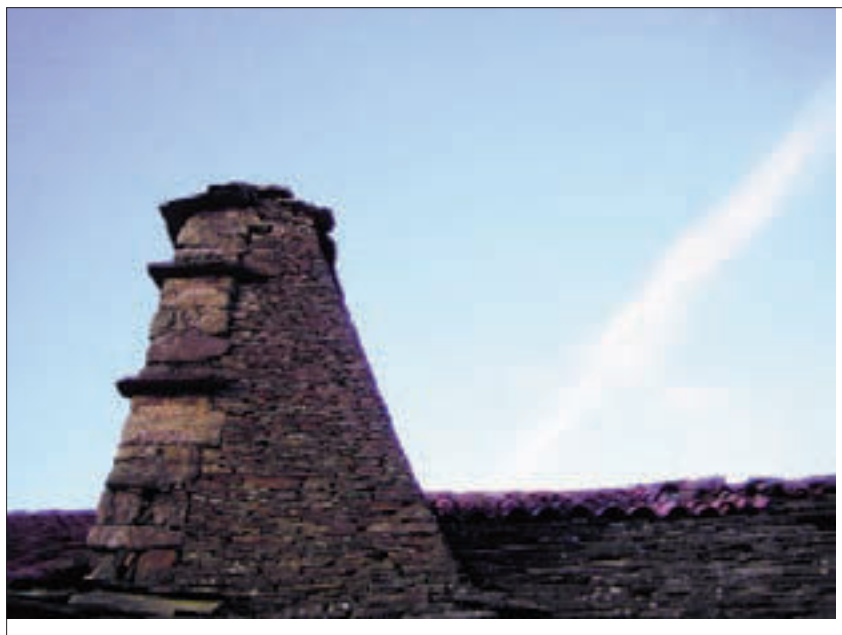
Chimenea de muro en Rebollar.
