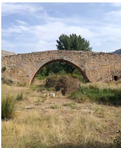
Puente y río seco (sept. 2017)
